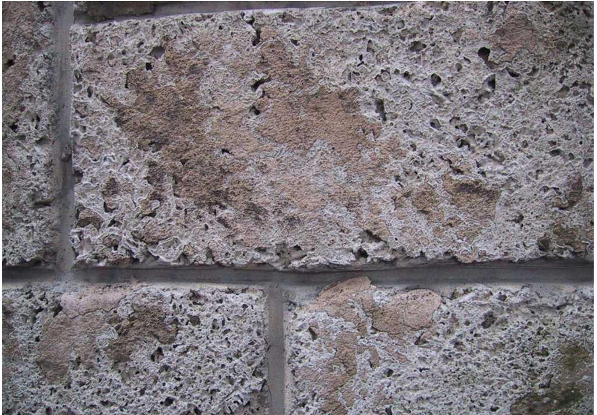
Kirche Enge, Zürich, Stopfmörtel in Sintertuff
