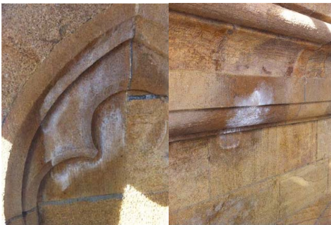
Photos extraites du PV de chantier No 108 (12.03.2012)
