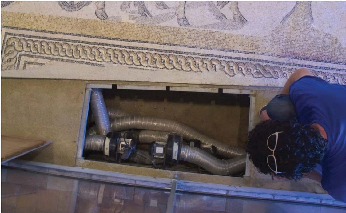
Figure 5 : Système de « ventilation intelligente » dans les tranchées des mosaïques. ©Etat de Vaud - Aventicum, 2013.
