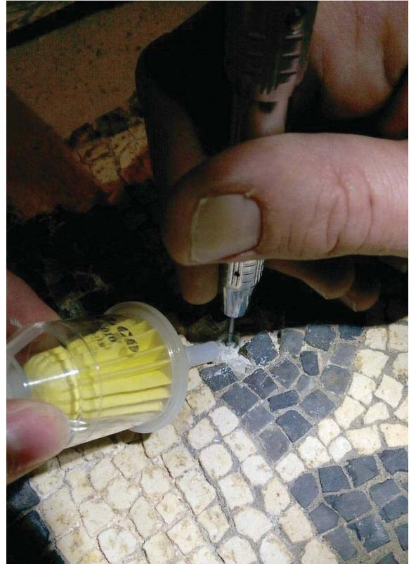
Figure 12 : Filtre et fraiseuse - le filtre aspire les
