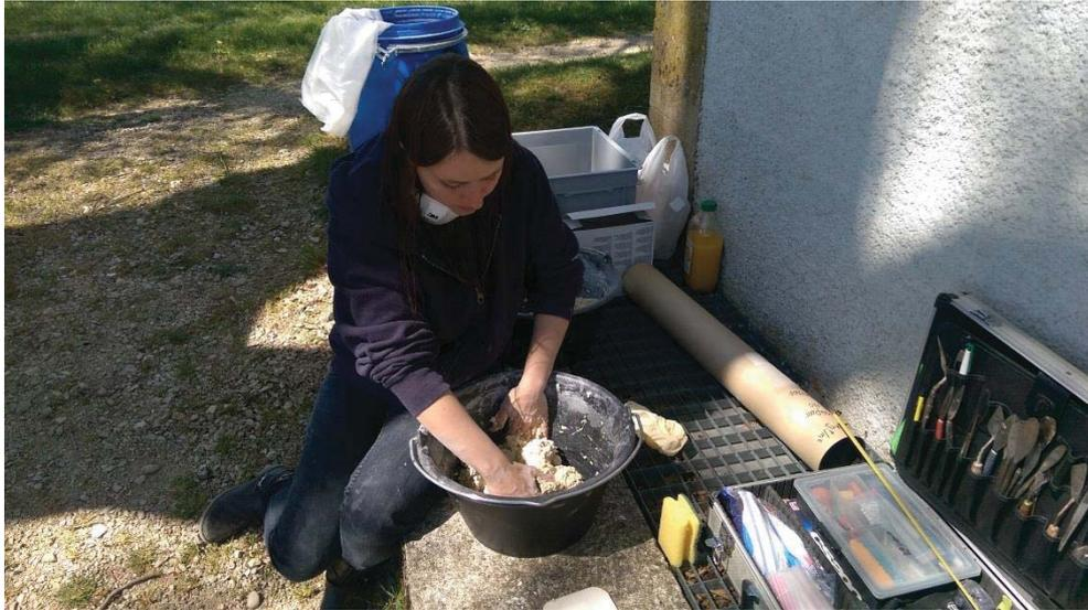
Figure 59 : Mélange de la pâte d'une compresse. ©HE-Arc CR, 2015.
