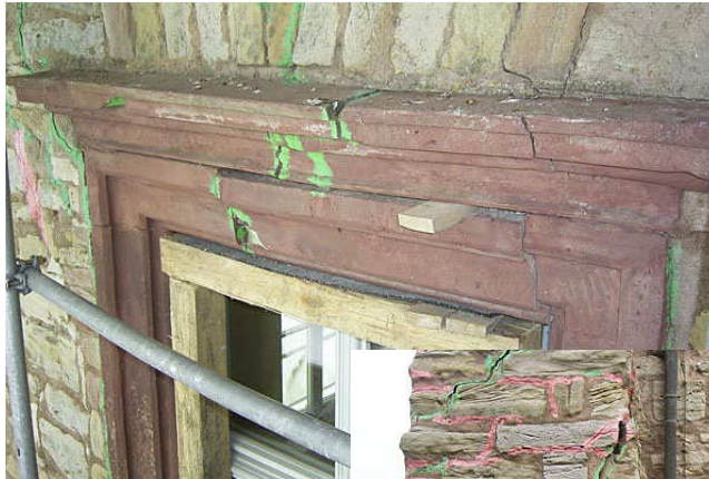
Damage after portland cement injection in Schloss Wiehe (D)
